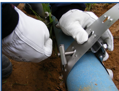
Approcher les deux parties du collier en les pinçant jusqu'au contact
