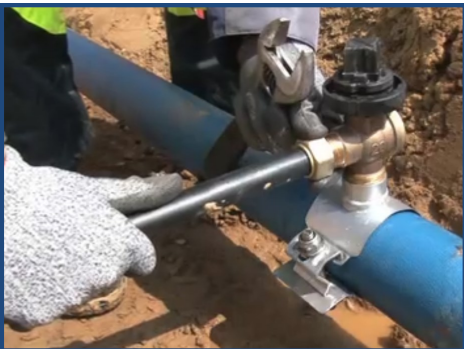
Mettre en place le PE
