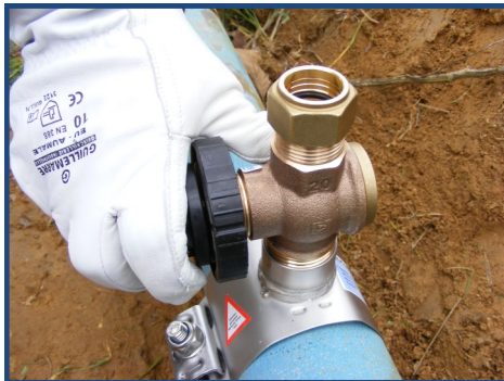
Visser le robinet de prise jusqu'au contact du joint
