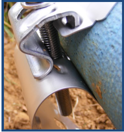
Sur fonte : serrer fortement (5 m.kg minimum)
