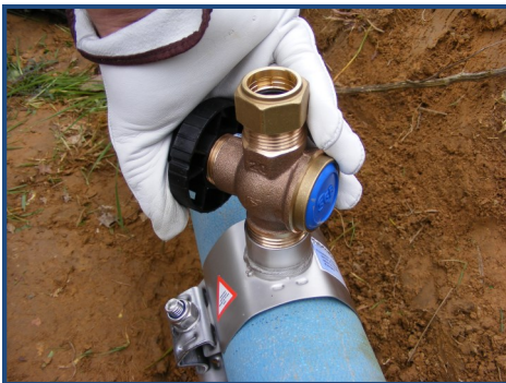
Effectuer au minimum 1 tour supplémentaire pour assurer l'étanchéité. Puis continuer le vissage pour orienter le robinet
