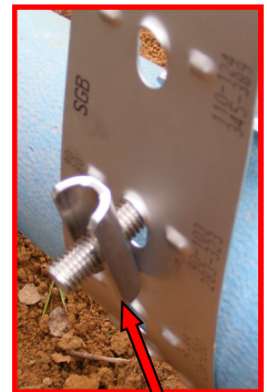
Mauvaise position du lopin
