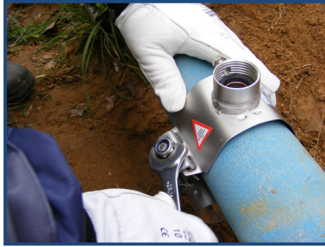
Avec une clé de 19, serrer jusqu'au contact inférieur de la bride avec la partie cintrée du collier
