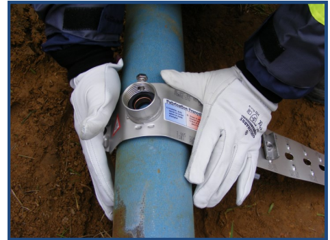
Poser le collier côté joint sur la canalisation et appuyer de chaque côté pour pré-former
