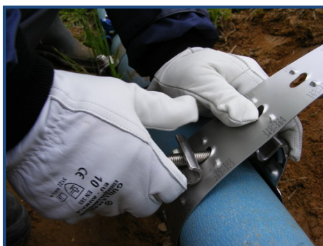
Visser manuellement le lopin le plus loin possible
