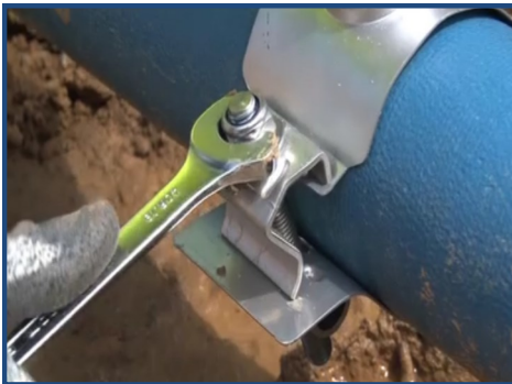
Resserrer en effectuant au minimum 3 coups de clé supplémentaires (équivalent à 1.5 tour de l'écrou)
