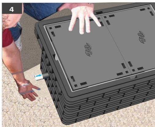
4 Connecter l'arrivée par manchon électro-soudable ou raccord à compression.
